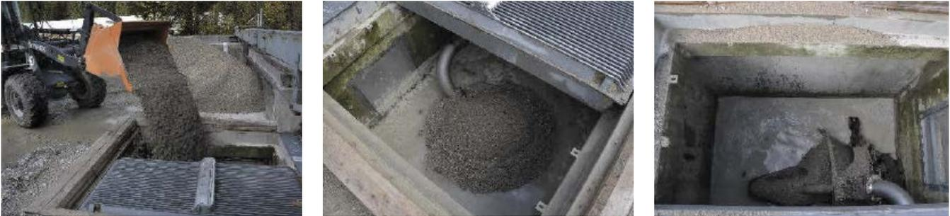
Abb. 8: Geschiebespülung mit Unterstützung der Rechenreinigung
