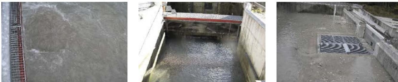
Abb. 12: Turbulenz am Saugschlauchende (li.), Ablagerung nach Durchgangsdrehzahl am Saugschlauchende (mi.) und im Einlauf (re.)
