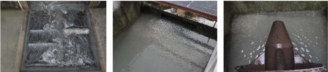
Abb. 10: Abflussvorgang mit Durchgangsdrehzahl und Spüleffekte
