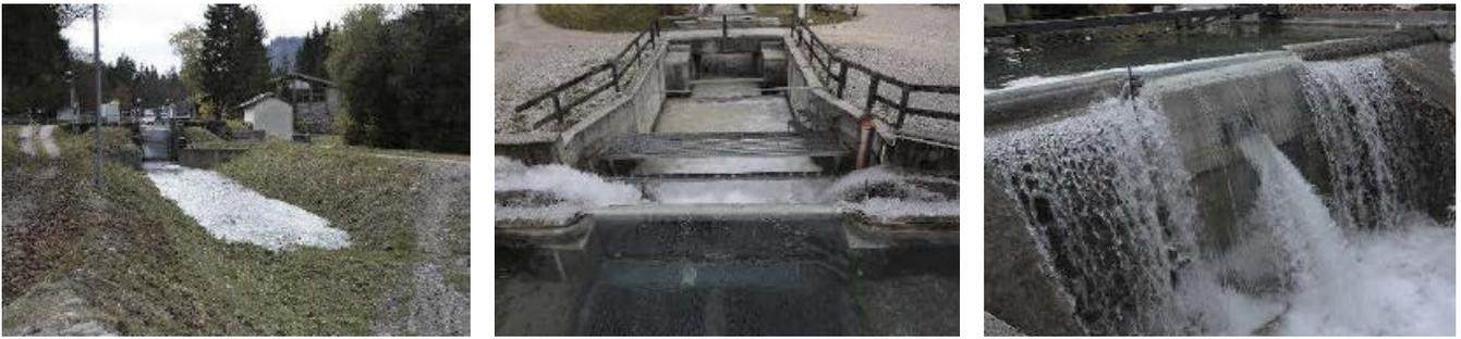
Abb. 9: Geschiebespülung mit Unterstützung der Rechenreinigung
